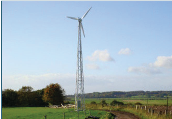
Abb. 2: Wer richtig plant und seine Nachbarn in die Planung mit einbezieht, kann an günstigen Standorten mit einer Kleinwindanlage Windstrom von der eigenen Wiese ernten.
