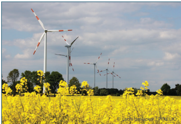
Abb. 1: Im Vergleich zu einzelnen Windenergieanlagen liefern Windparks höhere Stromerträge zu geringeren Betriebskosten.
