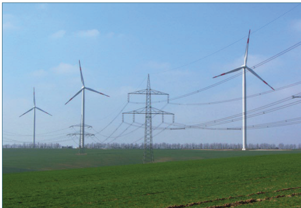
Abb. 6: Energielandschaften von heute sind durch große technische Strukturen geprägt: Windenergieanlagen und Hochspannungsleitungen in einer weiträumigen Agrarlandschaft.
